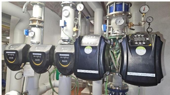
Questo intervento è seguito alla **riqualificazione della centrale termica del Centro Espositivo**, completato nel 2023, tramite la quale Villa Erba ha **sostituito integralmente il comparto caldaie** del centro Congressi. Il progetto è stato mirato a migliorare l'efficienza energetica e a ridurre i costi, aumentando la flessibilità del riscaldamento nelle sale per gli eventi.
